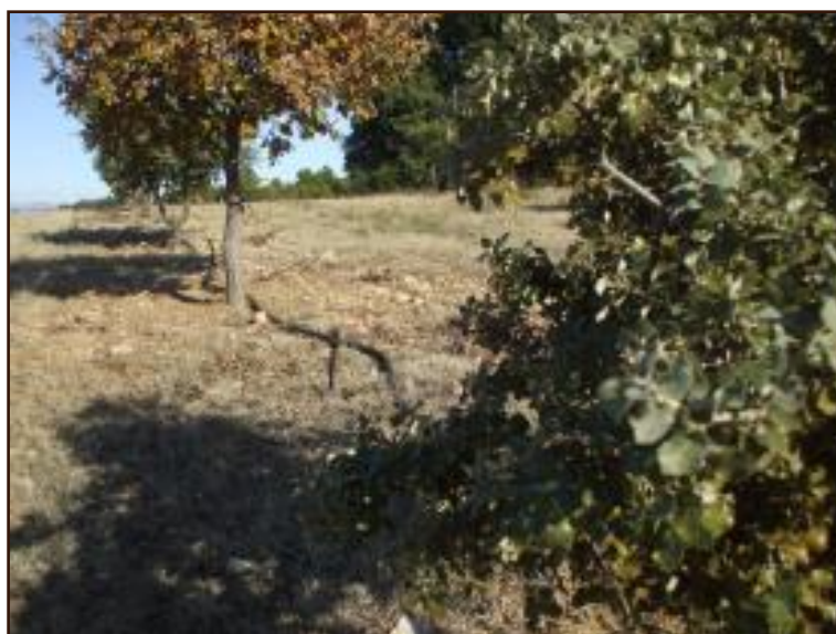
Asperseur installé à bonne distance des troncs
